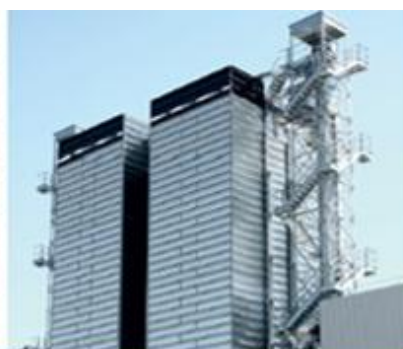
Полностью теплоизо- лированная шахта
