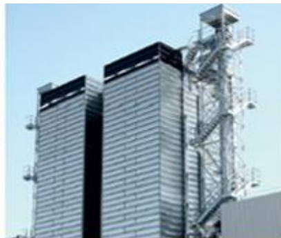
Полностью теплоизо- лированная шахта
