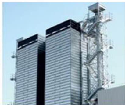
Полностью теплоизо- лированная шахта
