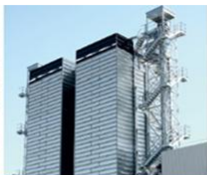
Полностью теплоизо- лированная шахта
